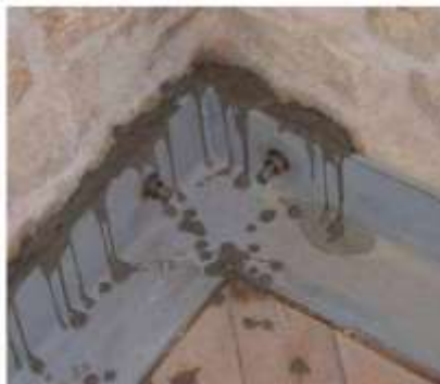
Connessione assito alla muratura
